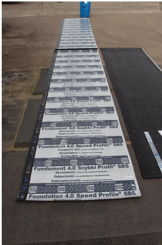
Przygotowanie papy Fundament 4.0 Szybki Profil SBS rozwińnięcie rolki
