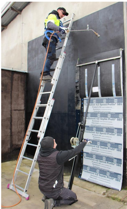
Kontynuacja prac do poziomu 4 m
