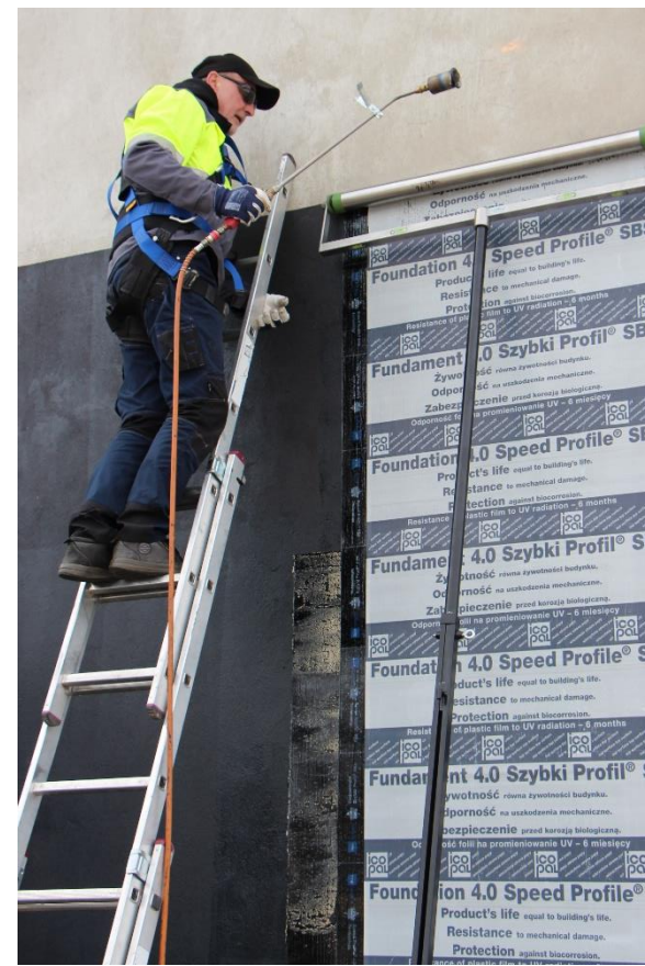
Następnie kontrolując wysokość wysunięcia wałka , dociska bryt papy do powierzchni utrzymując w tym stanie urządzenie do czasu zastygnięcia masy bitumicznej
