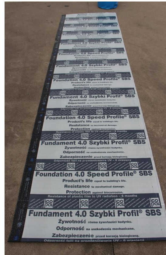
Przygotowanie papy Fundament 4.0 Szybki Profil SBS trasowanie / przycięcie na okreśłą długość np. 4,0 mb
