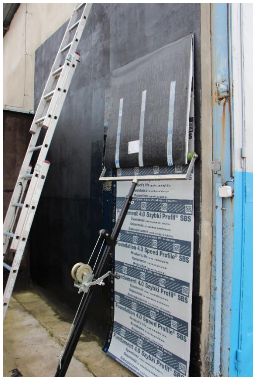
Opuszczenie rolki dociskowej do dolnego zakresu
