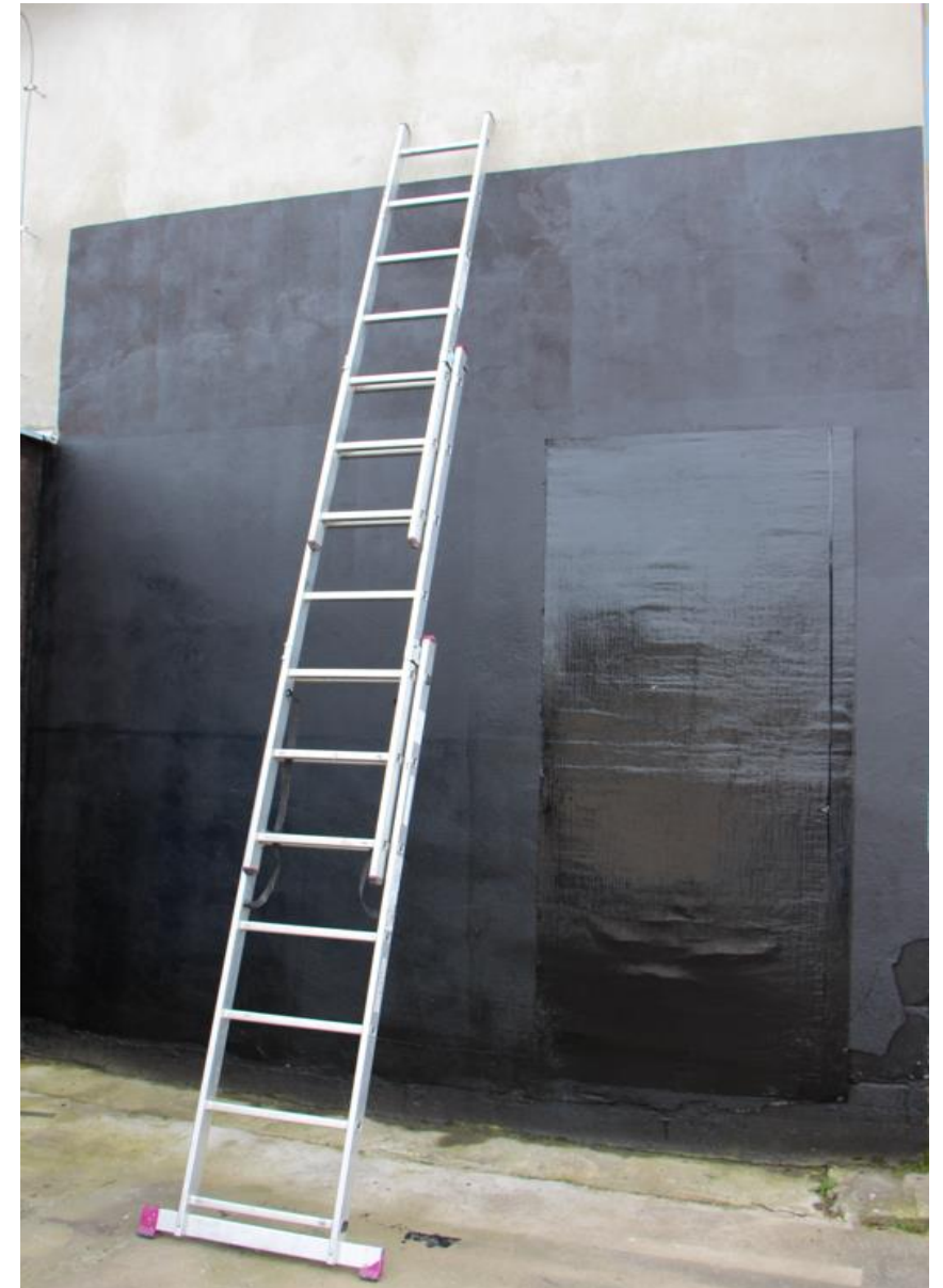
Przygotowana powierzchnia winna być w całości równa bez spękań, zagruntowana systemowym preparatem Siplast Primer po upływie dwóch godzin gotowa do instalacji papy w pionie
