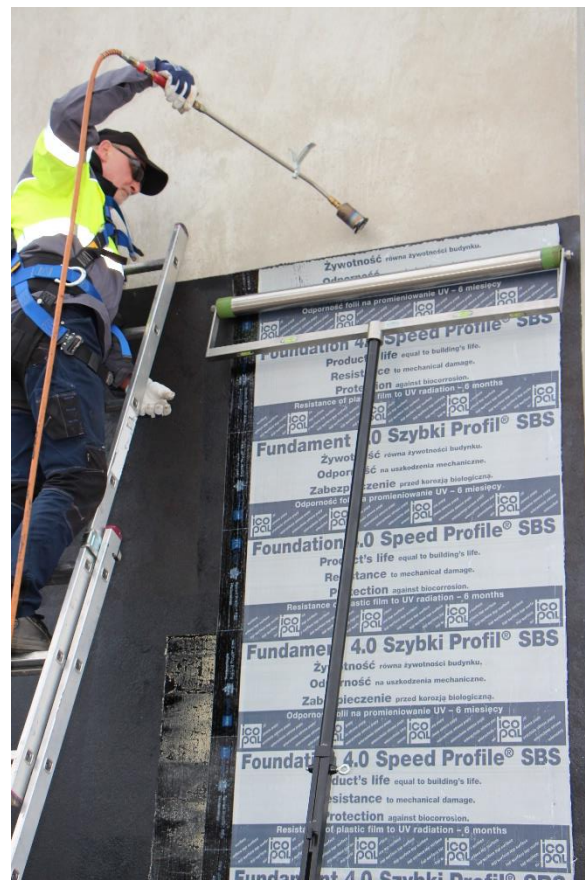
Dla wykonania prawidłowego wytopu masy bitumicznej na krawędzi górnej dekarz intensywnie wytapia bitum
