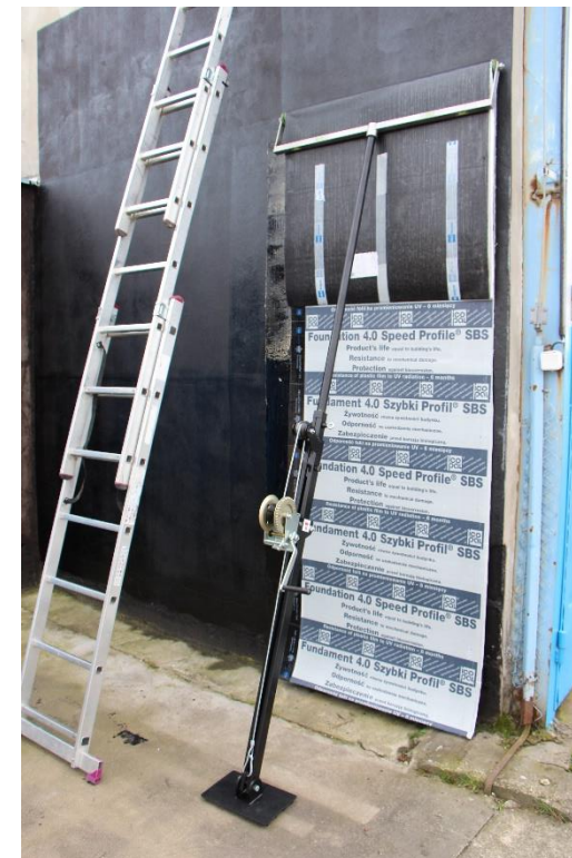
Podniesienie maszyny do miejsca w którym została przerwana instalacja _ kontynuacja pracy
